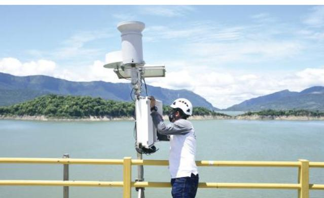
Este tipo de estaciones se encargan de la medición de variables como temperatura, humedad, precipitación, evaporación, niveles y caudales de los diferentes cuerpos de agua que alimentan el embalse, lo que nos permite evaluar los datos arrojados para hacer control y alertar o prevenir a las comunidades sobre el comportamiento del **embalse Topocoro**, posibles inundaciones o vertimientos controlados.
